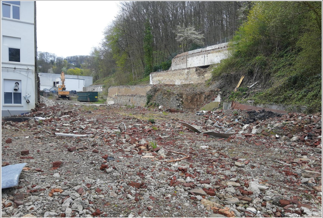
Abbildung 7: Ehemalige Tapetenfabrik nach Teilabriss am 11.04.2024, Blick nach Norden
