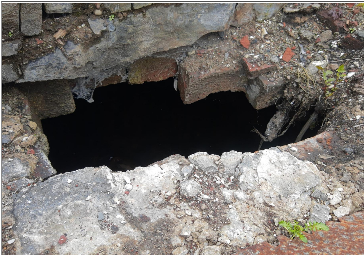
Abbildung 9: Geöffnetes Gewölbe am "Gummersbach" im Bereich der zurückgebauten Gebäudeteile am 11.04.2024
