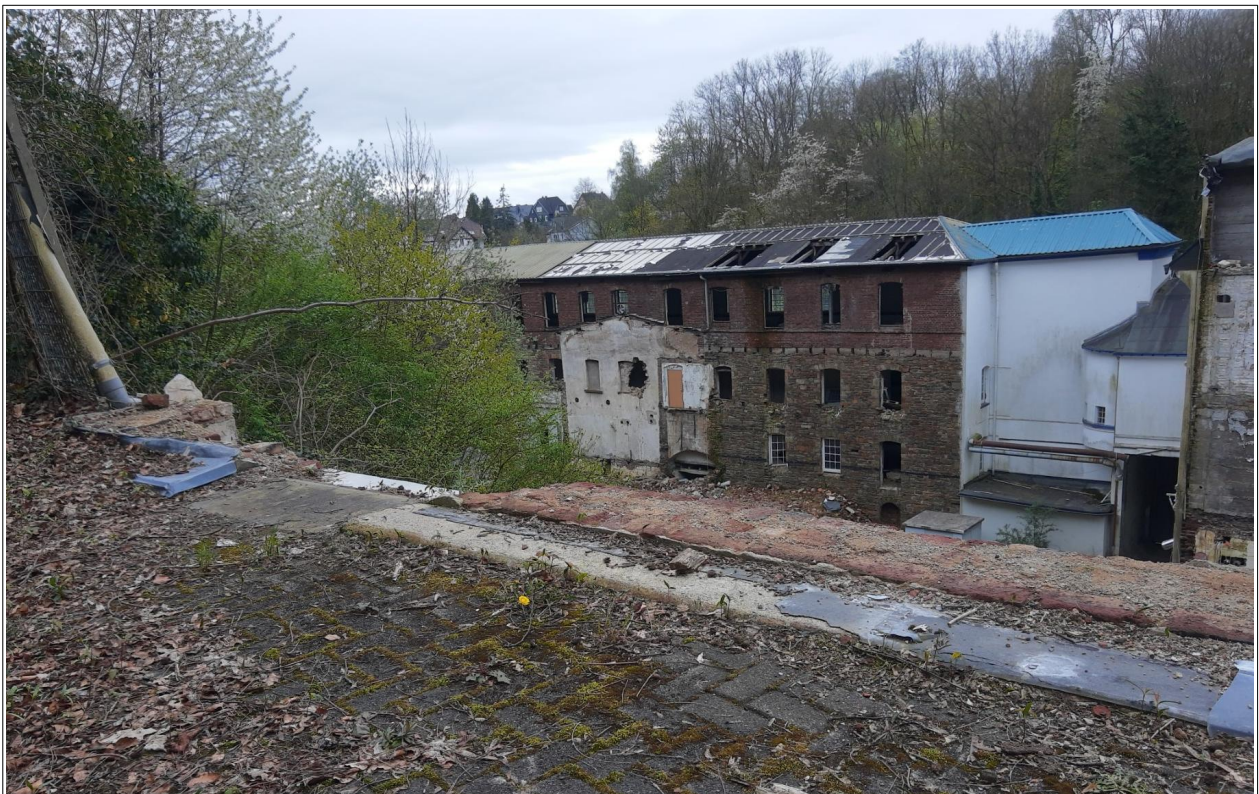
Abbildung 8: Ehemalige Tapetenfabrik nach Teilabriss am 11.04.2024, Blick vom Denkmalweg nach Südwesten
