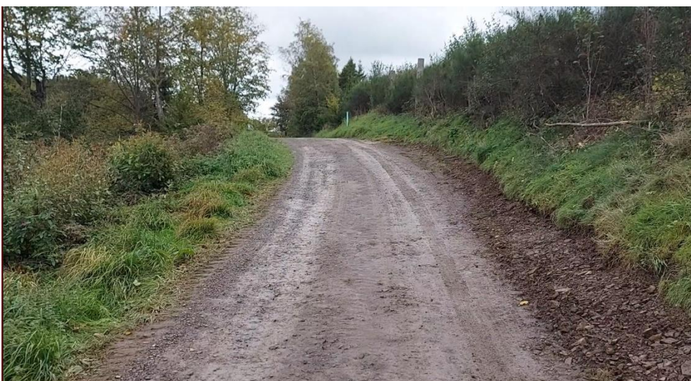
Wirtschaftsweg, der verbreitert wird. Rechts verbuschte Vorwaldbestände. Links Böschungen zur K60.
