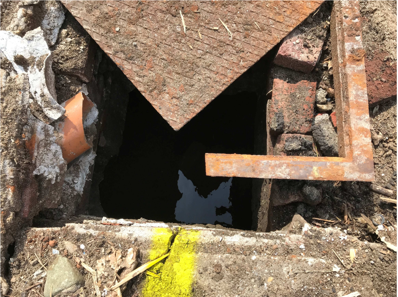
Abbildung 5: Foto vom 27.04.2023: Schachtbauwerk des verrohrten Gummersbaches
