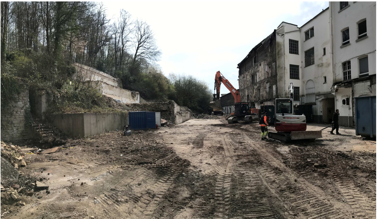
Abbildung 6: Blick in südliche Richtung, links Terrassen des abgerissenen Bürogebäudes (Stand 27.04.2023)
