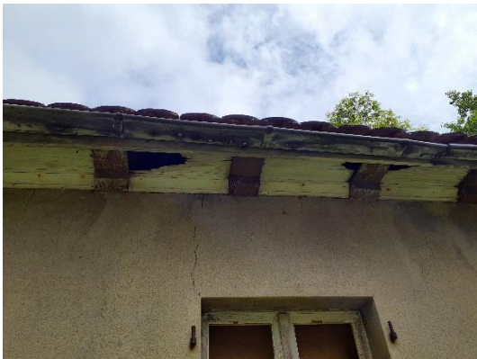
Abb. 10 Öffnung zum Dachstuhl.
