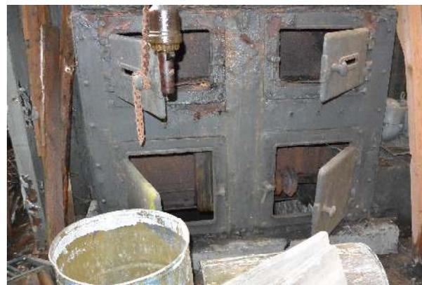
Foto 11: Heizkammern mit Kesselklappen
