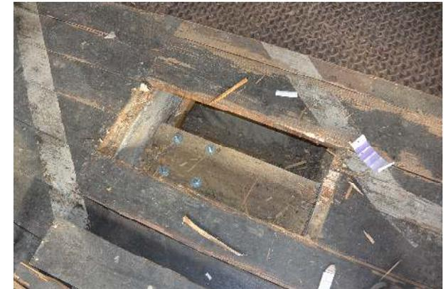
Foto 42: 1. OG Holzdielen mit Hohlboden, Produktions- und Lagerhalle
