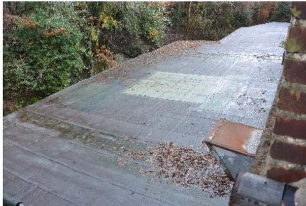
Foto 16: Dachpappeneindeckung Produktions- und Lagerhalle (Hangseite)
