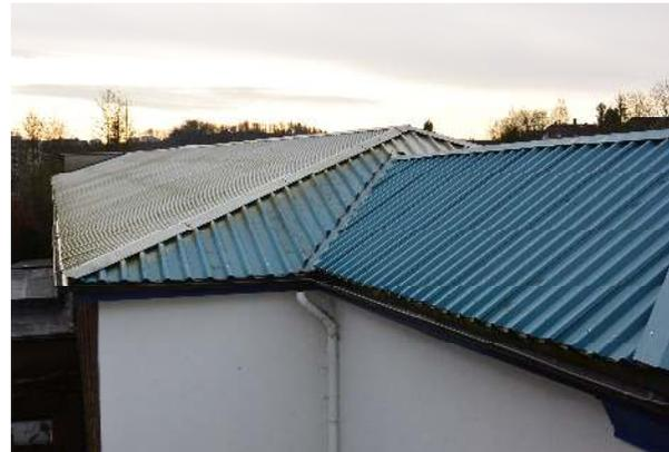
Foto 17: Trapezblecheindeckung Produktions- und Lagerhalle (Str.-S.)
