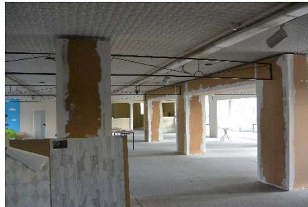
**Foto 38:** Styropordeckenverkleidung, 3. OG, Bürogebäude (Hangseite)
