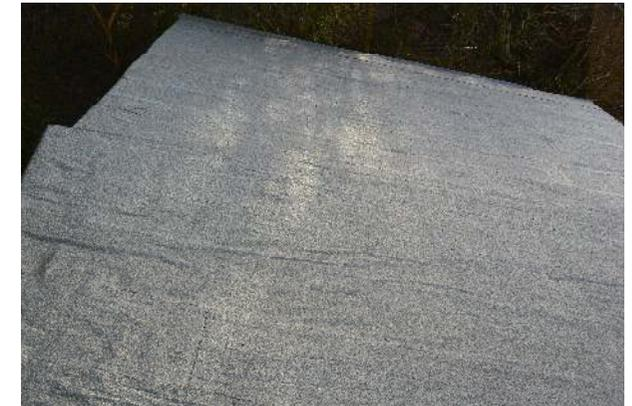
Foto 18: Dachpappeneindeckung Anbau Bürogebäude (Hangseite) + Garage
