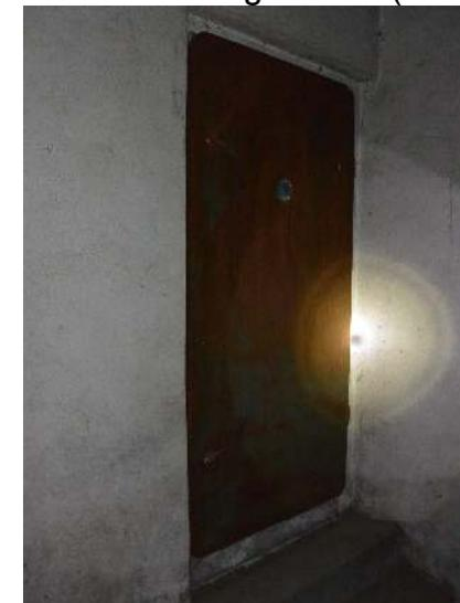
Foto 21: Feuerschutztür im KG Bürogebäude (Str.-S.)
