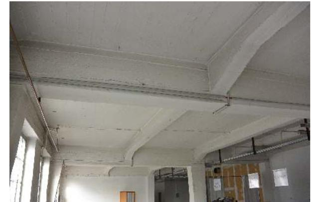
Foto 30: Betondecke / -unterzüge 2. OG, Bürogebäude - Treppenhaus
